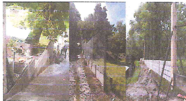
Foto 4: Durante construcción de muro perimetral con block y malla galvanizada.
