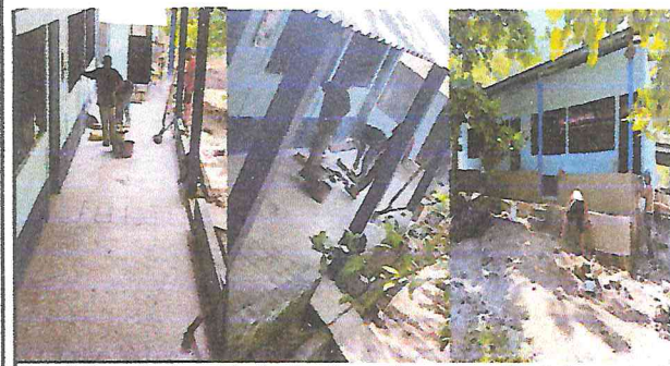
Foto 5: Durante el cambio de piso de granito y reparación de banqueta de concreto.
