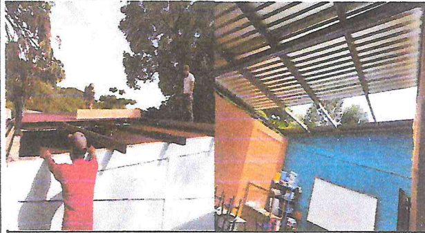
Foto 1: Durante sustitución de lamina de dos aulas.
