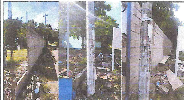
Foto 3: Durante construcción de muro perimetral de block.
