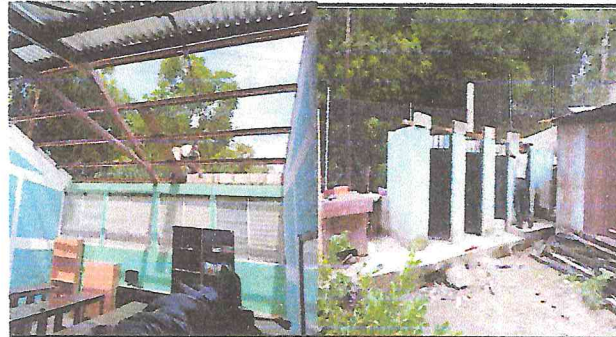
Foto 2: Durante la sustitución de lamina del cuarto tecnológico y sanitarios.
